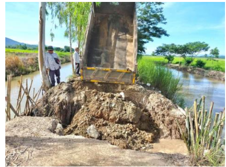
ซ่อมแซมถนนที่ชำรุด เนื่องจากฝนตกหนัก บริเวณหมู่บ้านปากกล้วยแช่และบ้านใหม่แก่นคำ
